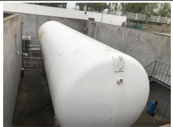
下沉式 60m<sup>3</sup>LNG 液化罐
