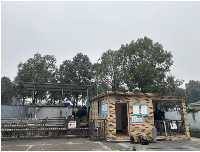
污水处理站及其排口
