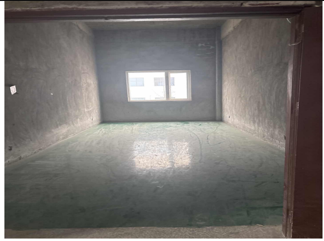
危险废物暂存间
