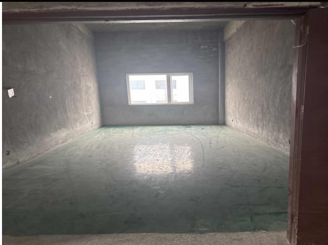
危险废物暂存间
